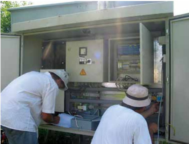
Костолац, Површински коп Дрмно, април 2004, монтажа и тестирање опреме за експериментална истраживања на бунару PLB-II-5 даљинског надзора и управљања одводњавањем рудника
