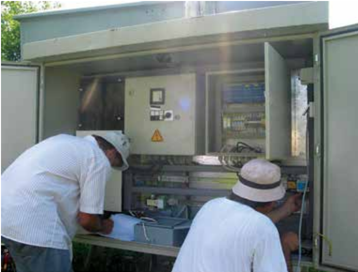
Костолац, Површински коп Дрмно, април 2004, монтажа и тестирање опреме за експериментална истраживања на бунару PLB-II-5 даљинског надзора и управљања одводњавањем рудника
