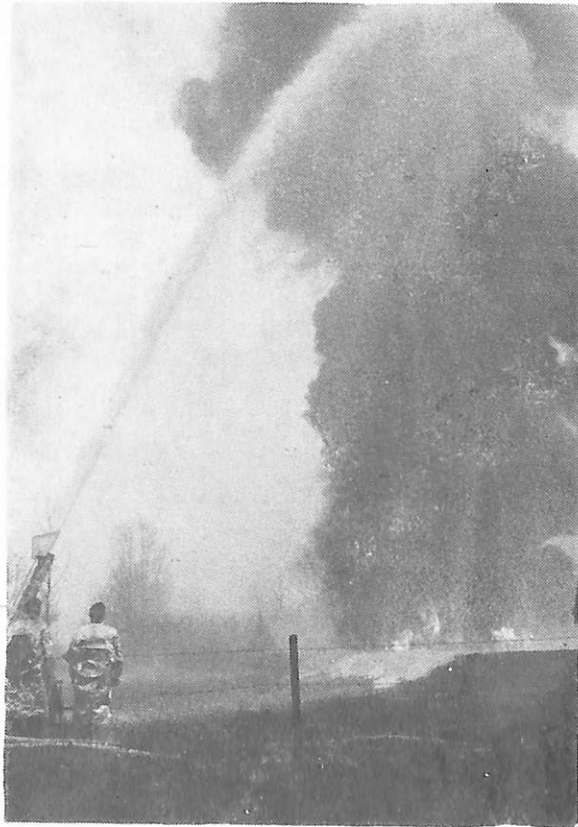
Sl. 5 — Bacač Minimax LW-2000 bacio je mlaz pjene uvis preko 25 m. Iako je mlaz pjene jako raspršen, pjena ipak kroz vruće plinove i vatru uspješno stiže do goruće površine i gasi
