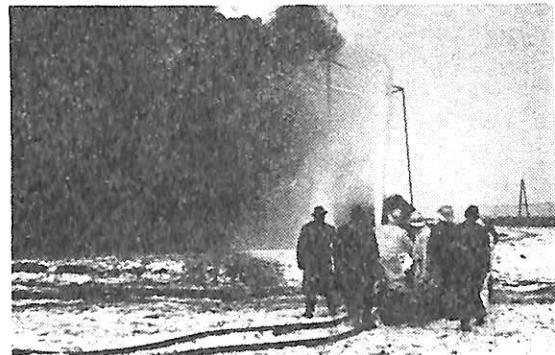
Sl. 2 — Početak uspješnog gašenja pjenom Light Wateria. Topom bačeni mlaz pjene iznad »spremnika« probija se kroz vruće plinove na površinu zapaljene nafta i odmah gasi vatu.
