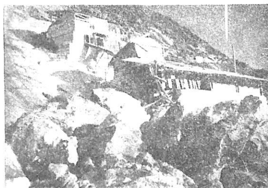
Sl. 2 — Odron i oštećeni pogonski uređaji u kamenolomu »Perun«.
