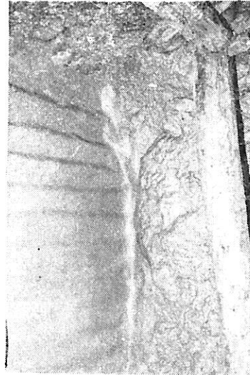
Sl. 36 — Izgled desnog boka pregrade. Fig. 36 — View of brattice right flank.
