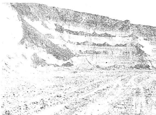
Sl. 3 — Stabilne etaže površinskog otkopa u peskovitom tlu
