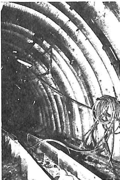
i da obezbedi kompletan hodnički podgradni sistem: izuzetno brzo i lako sklapanje i odgovarajuću zaštitu od padajućeg kamenja neposredno po privremenom montiranju. Konačna nosivost se ostvaruje tokom druge i treće podgradne faze uporedo sa izradom hodnika zasipanjem materijalom i ankerovanjem.
