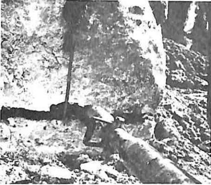
ubacuje se deblji klin za proširivanje pukotine. Prema tome, koriste se dva cilindra za cepanje, od kojih je jedan stalno pod naponom, za izradu pukotina širine 50 do 70 mm u kamenu ili betonu za vrlo kratko vreme.
