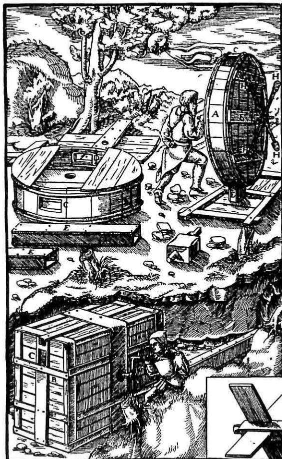
Sl. 25 – Mašina za provetrvanje podzemnih prostorija. A – bubanj; B – četvrtasti sud; C – otvor za vazduh; D – drugi otvor; E – cev za vazduh; F – osovina; G – ručica za okreće; H – zamajne šipke; detalj lopatica (bez oznake).
