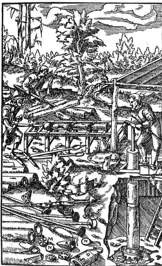
Sl. 17 – Klipna pumpa sa prostim ručnim pokretanjem. A – sabirnik za vodu u oknu; B – cev; C – podgradni okvir okna; D – usisna glava; E – rupe na glavi; F – usisni ventil na prstenu; G – izlivna cev; H – klipna motka; I – držak; K – levkasti klip; L – klip sa okruglim rupama; M – klip sa duguljastim rupama; N – kožni ventil; O – radnik koji buši oblice i od njih pravi cevi; P – spiralno svrdlo; Q – kašikasto svrdlo.
