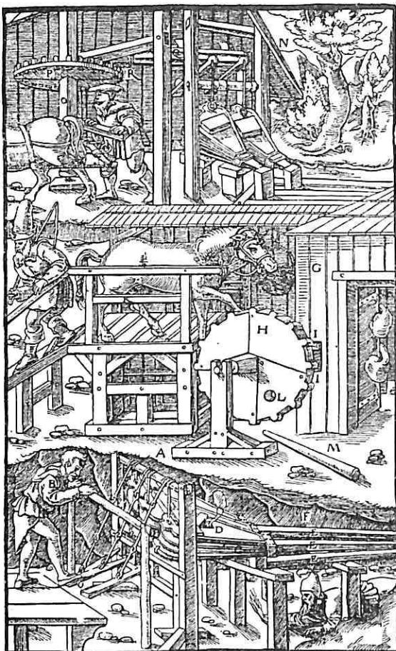
Sl. 26 – Mašine za provetrvanje podzemnih prostorija. A – prethodno opisana mašina; B – radnik sabija vazduh gaženjem mehova; C – mehovi bez piska; D – otvor za ispuštanje lošeg vazduha; E – cevi za vazduh; F – potkop; G – druge mašine; H – drveni buben; I – prag; K – ograda; L – okrugli otvor; M – motka; N – treća mašina; O – vertikalna osovina; P – zupčanik; Q – horizontalna osovina; R – pogon.
