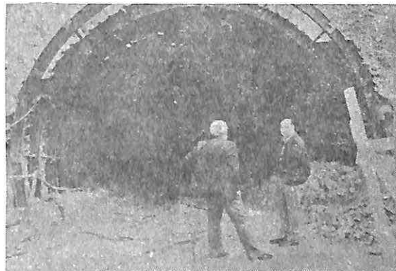
Sl. 1 — Fotografija podgrade od čeličnih remenata (uskop u Velikom Krivelju).
