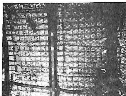
zasip betonskog tipa. Montoplast polietilenски cilindar ima dovoljno istezanje da zapuni nepravilne šupljine između podgrade i stena pod pritiskom koji vrši napunjeni cilindar.
