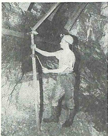
zastiranjem krovnih lukova, hodnici se zaštićuju ovom lakom visinski podesivom podgradom dužine od 1,7 do 3m u kombinaciji sa žičanom mrežom. To ne ometa postavljanje i zastiranje podgrade hodnika. Poligon podgradu je ispitao federalni Zavod za ispitivanje materijala i odobrio za primenu Rudarski inspektorat Severna Rajna, Vestfalija.
