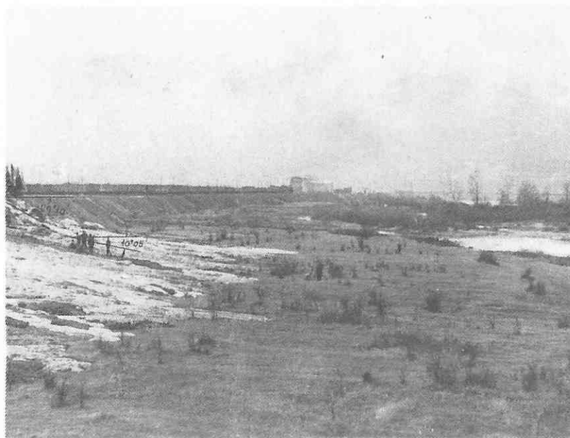
Sl. 10 — Deponija visokopećne šljake izlivene u užarenom stanju direktno u deponiju u Zenici.
