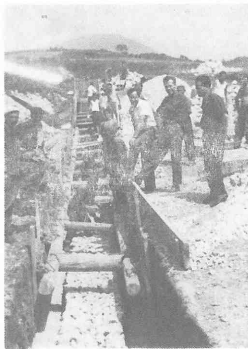
Sl. 7 — Izrada bočnih drenova sa osiguranjem iskopanog rova.
