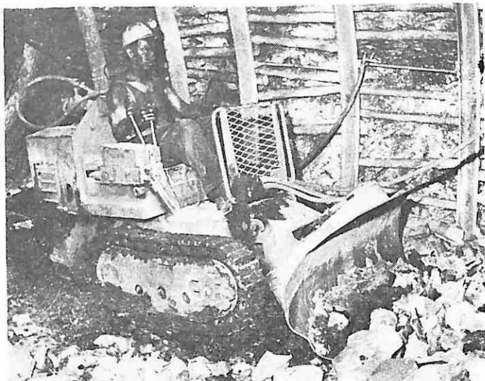
Najveći: Salzgitter utovarač sa bočnim istresanjem HL 583 I kreće se pomoću gusenica sa lopatom zapremine 1200 l., širinom lopate 2400 mm, visinom bacanja 1900 mm i težinom od 9,5 t. Kod tog utovarača može se lopata držati na svakoj željenoj visini do maksimalno 2150 mm i može se koristiti kao radna platforma.
