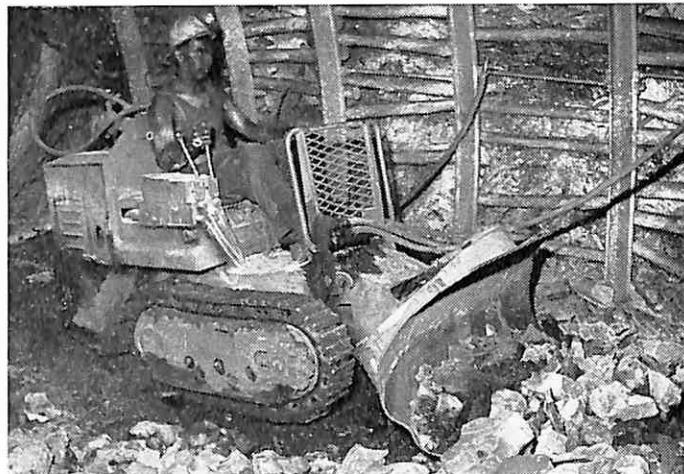
Najveći: Salzgitter utovarač sa bočnim istresanjem HL 583 H kreće se pomoću gusenica sa lopatom zapremine 1200 l., širinom lopate 2400 mm, visinom bacanja 1900 mm i težinom od 9,5 t. Kod tog utovarača može se lopata držati na svakoj željenoj visini do maksimalno 2150 mm i može se koristiti kao radna platforma.
