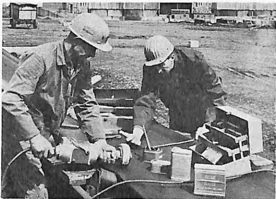
Firma NILOS GmbH Förderband — Ausrüstung iz Düsseldorfa razvila je i tokom svog dugogodišnjeg rada usavršila jedan brz i efikasan postupak otklanjanja oštećenja na transportnim trakama (reparturni postupak NILOS-KALT).
