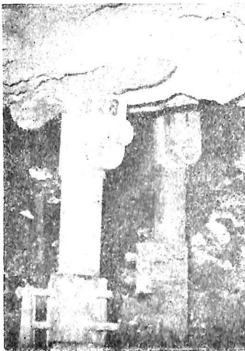
Sl. 1 — Merne hidraulične čelije ugradene na otkopu br. 34 jama „Milićevci“ — rudnik „Sumadija“. Abb. 1 — Hydraulische Messungzellen am Abbauort №. 34 der Grube „Milicevci“ — Bergwerk „Sumadija“ eingebaut.
