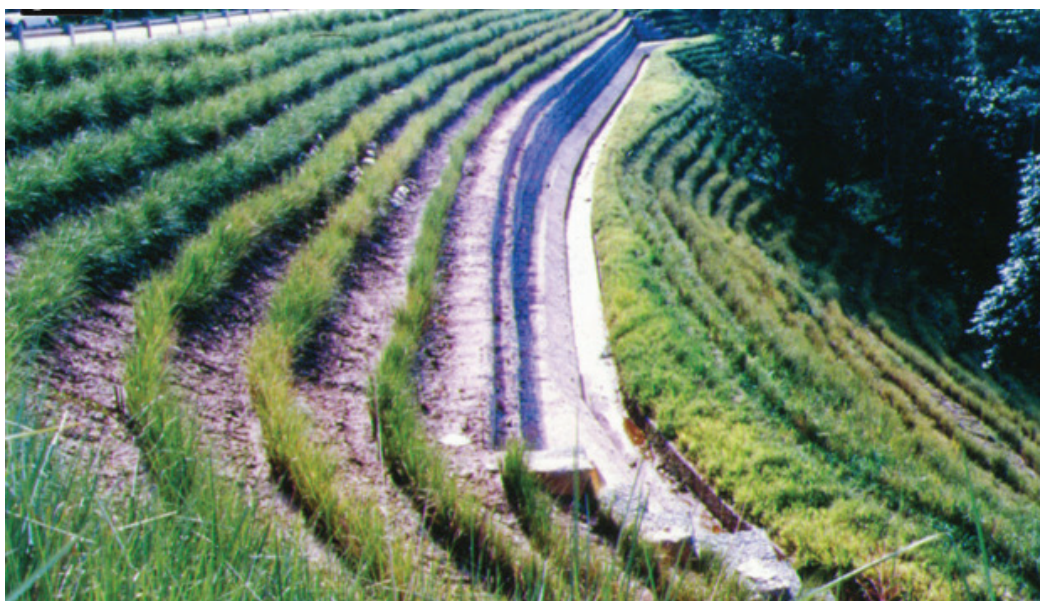
Слика 6, Пример очвршћивања косина системом ветивера Figure 6, Example of vetiver system strengthening of slopes
