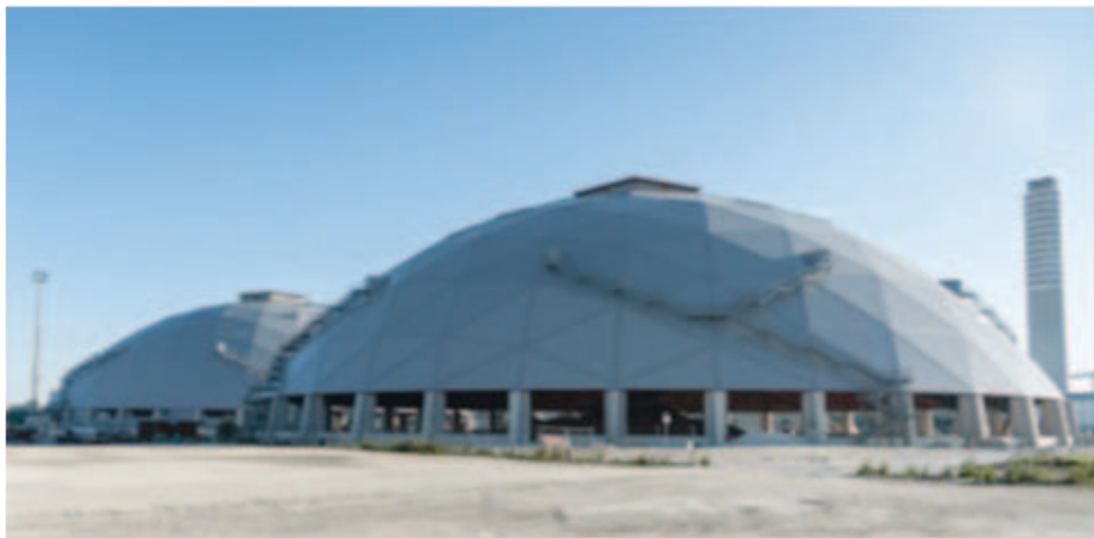
Слика 3, Покривено складиште угља у Италији Figure 3, Covered coal storage in Italy
