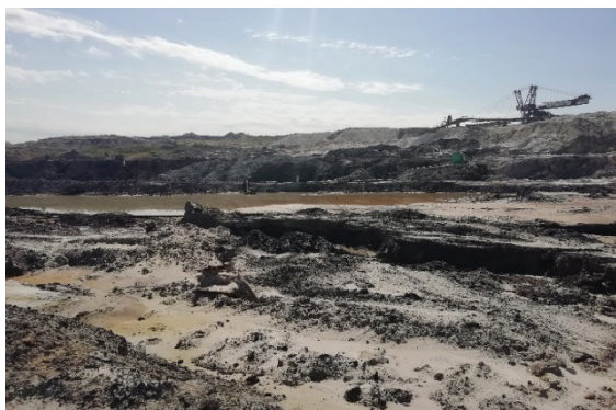
Слика 2, ПК Поље Ц - акумулисана вода у ножици одлагалишта, 1.09.2020. [2]
