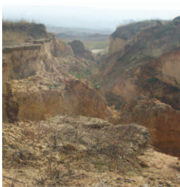
Слика 3, Ерозија северне границе ПК Поље Б [5] Figure 3, Erosion of the PK Field B northern border [5]
