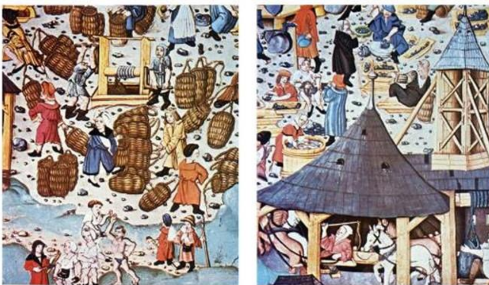
Римска епоха, пребирање, чишћење и прање руде, лево – извозно окно са витлом на ручно покретање, десно – са коњском вучом [26]
