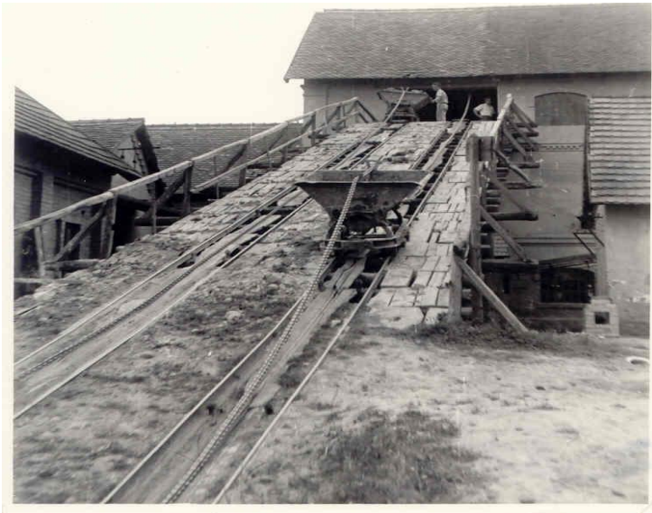
Кањижа, горе – радови на откопавању и утовару глине, доле - навозиште у погону циглане
