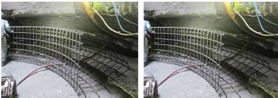
Слика / Figure 5, Радови у окну / Work at the site in shaft
