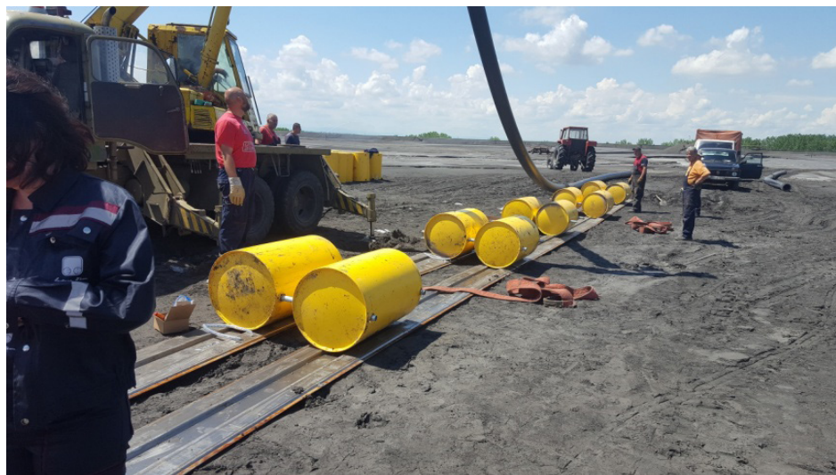
Слика / Figure 5, Монтажа пројектно дефинисане опреме на депонији пепела / Assembly of the equipment defined by the project at the landfill of ash
