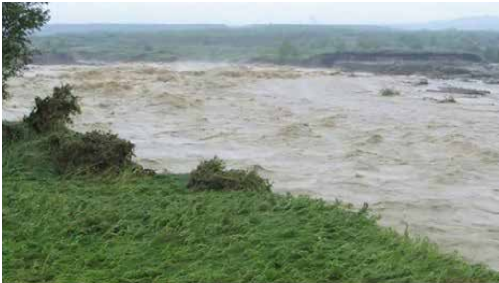
Слика / Figure 7, Уливање Колубаре у ПК „Тамнава Источно поље“ на месту пробоја новог заштитног насипа / Estuary of Kolubara into OP „Tamnava East field” at the place where the new protective embankment was pierced
